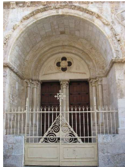
Il portale nord di S. Maria Latina / chiesa del Redentore oggi
